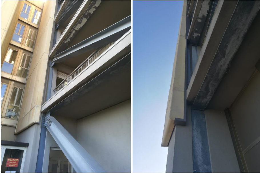
Figura 2-24 Dettaglio elementi di tamponamento
