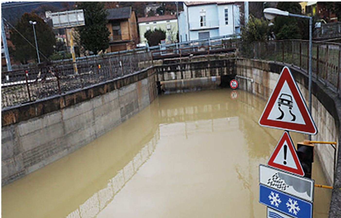
> Figura 4.3.5 Sottopasso stradale allagato (Fonte: CAMILab).
