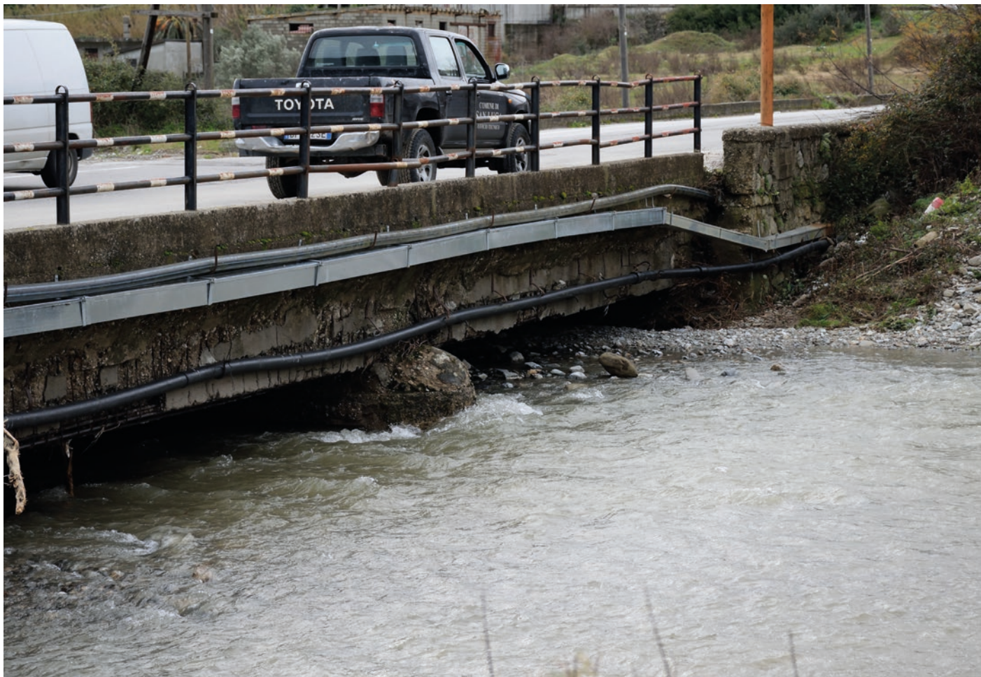
> Figura 4.3.1 Tratti di alveo sovralluvionato (Fonte: CAMILab).
